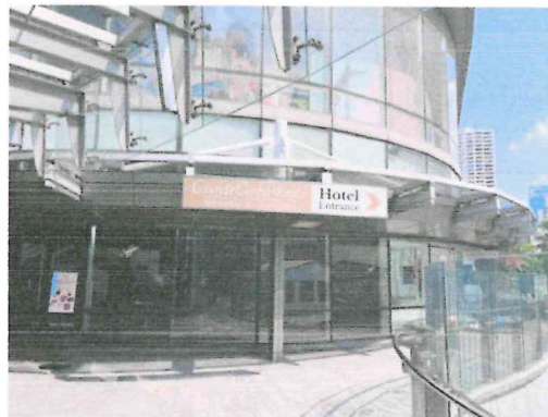
ภาพ ทางเชื่อมระหว่างสถานีรถไฟฟ้า BTS อโศก และโรงแรม Grande Centre Point Terminal 21
