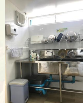
บริเวณเตรียมล้างอุปกรณ์
