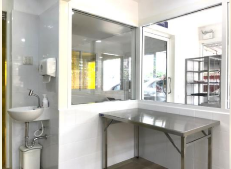
บริเวณซึ่งใส่ถ้วย ห้องผสมก่อนและหลังปรับปรุง
