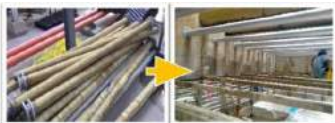
รูปที่ 3 แสดงการเปลี่ยนท่อฉีดน้ำเป็นละอองฝอย (SPRAY PIPE)
