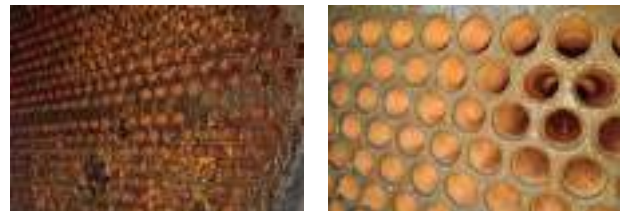
ก่อนการติดตั้ง
