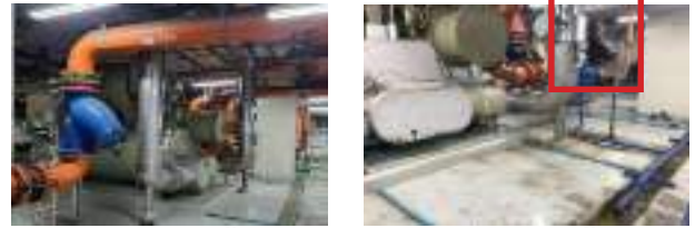
ก่อนการติดตั้ง
