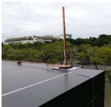
รูปที่ 8 แท่งตัวนำล่อฟ้าแบบแฟรงกลินปลายทู่
