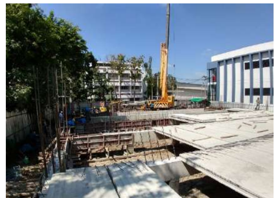
รูปภาพที่ 3 ภาพการวางแผ่นพื้นสำเร็จอาคารเก็บเอกสาร
