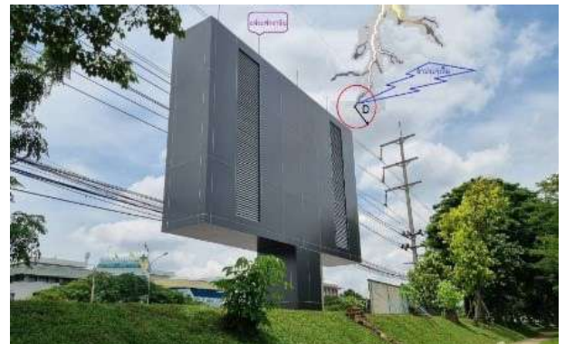
รูปที่ 7 การเกิดฟ้าผ่าลงป้ายประชาสัมพันธ์ Digital Signage ตามหลักคิดแบบทรงกลมกลิ้ง
