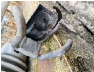
รูปที่ 7 ภาพครีปอาร์คฟิวส์ เฟส C ที่เกิดความร้อนบริเวณหน้าสัมผัสของกระบอกฟิวส์
