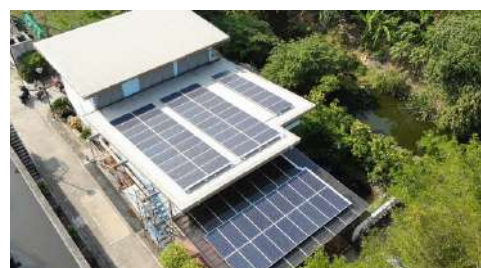
รูปที่ 2 การติดตั้งระบบระบบผลิตพลังงานไฟฟ้าจากพลังงานแสงอาทิตย์บนหลังคา อาคารสำนักงานระบบบำบัดน้ำเสียรวม
