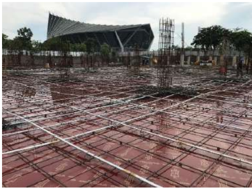
รูปภาพที่ 5 รูปภาพงานเหล็กเสริมและลวดสลิงระบบ Post-Tension อาคารจอดรถ
