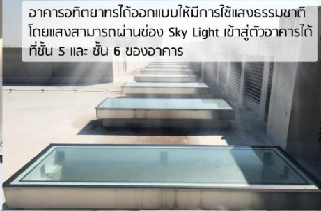
แสงจากธรรมชาติสามารถเข้าสู่ตัวอาคารได้โดยผ่านช่อง Sky Light ที่ชั้นดาดฟ้า
