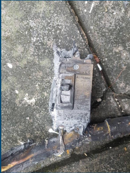
Circuit Breaker ขนาด 50 AT
