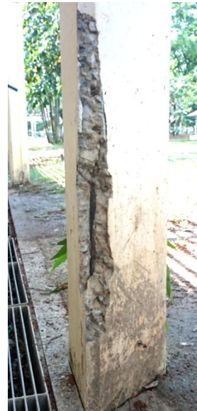
— cover way โครงสร้างคอนกรีตเสริมเหล็ก ก่อสร้างประมาณปี 2522 อายุ 39 ปี
