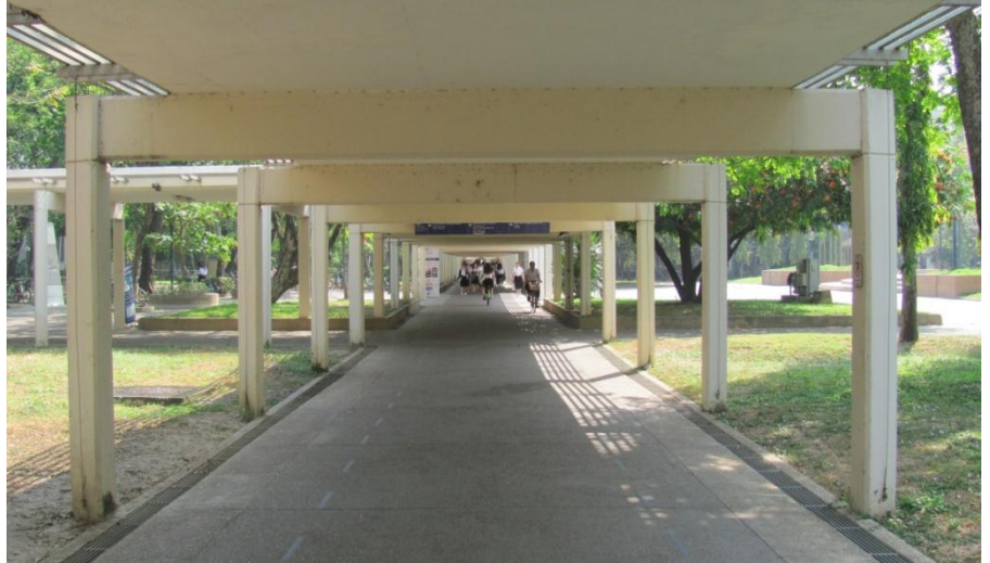
— cover way โครงสร้างคอนกรีตเสริมเหล็ก ก่อสร้างประมาณปี 2522 อายุ 39 ปี
